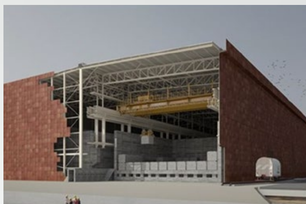
Схематическое изображение хранилища для отходов категории А
